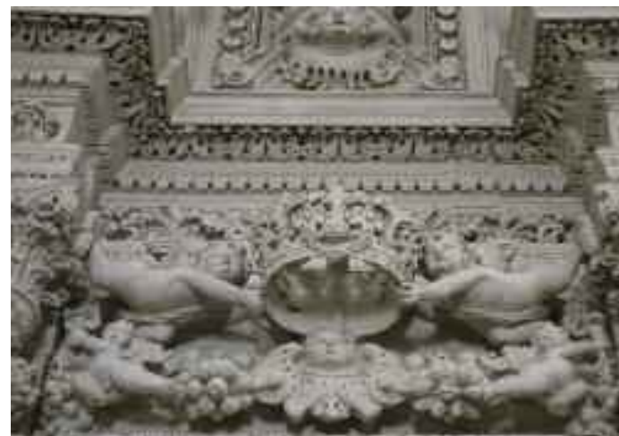
Ruffano, Chiesa del Carmine, particolare dell'altare maggiore
