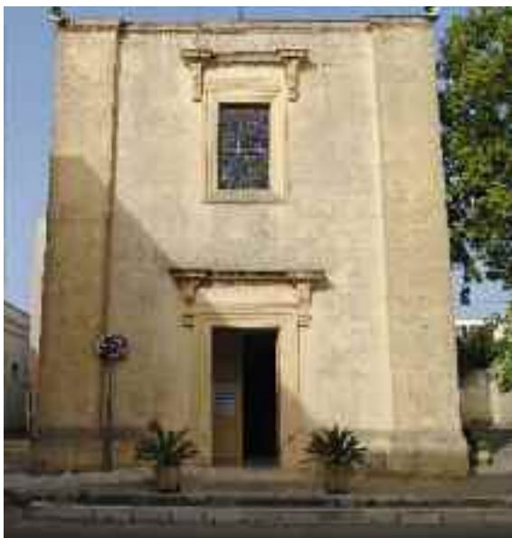
Chiesa di San Vincenzo, esterno
